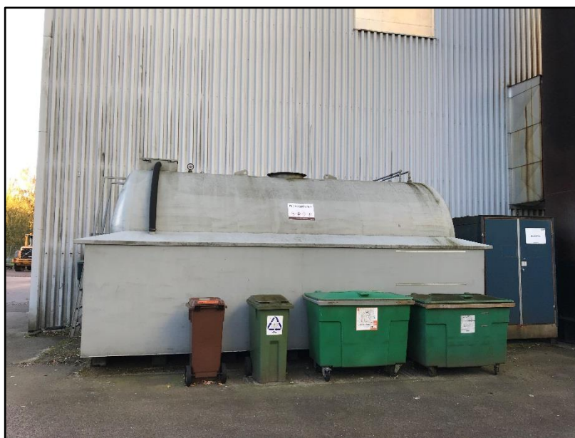
Figur 5 Cistern för bioolja till oljepannorna samt avfallsbehållare. Till höger i bild finns miljöstation för farligt avfall.
