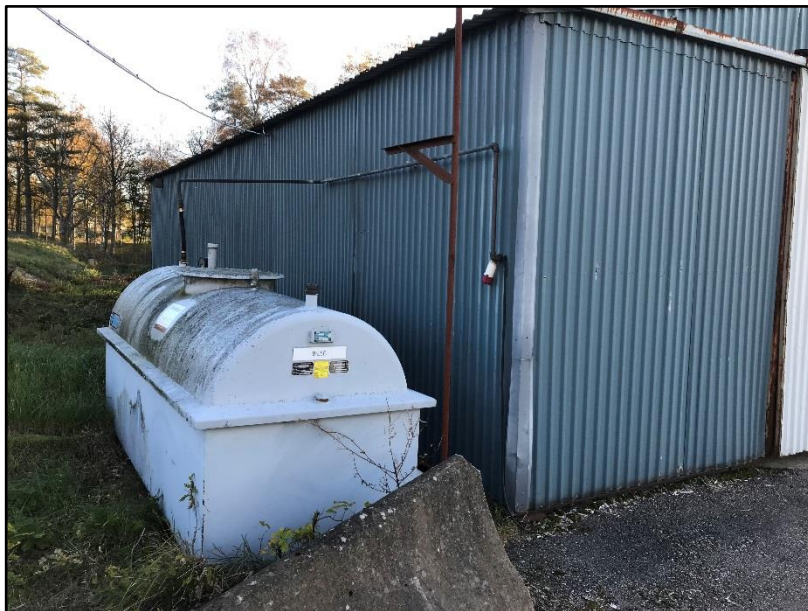
Figur 7 Cistern för diesel
