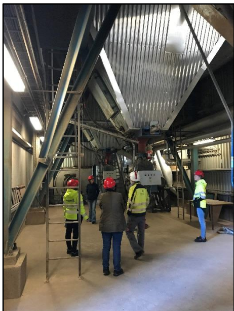
Figur 13 Silo för bränsle
